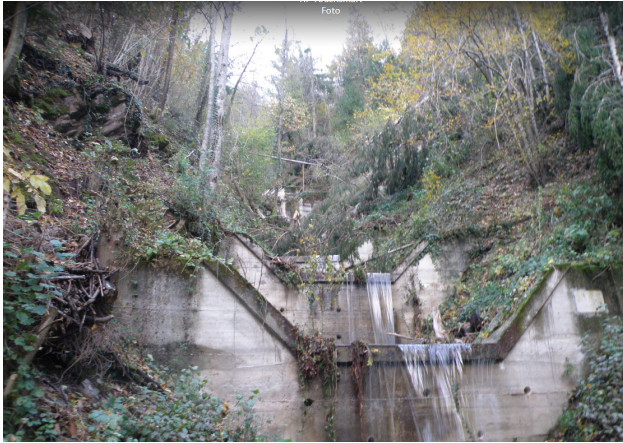
Briglie intasate da piante prima della pulizia del 1/11/18 (rif. su mappa: G)
