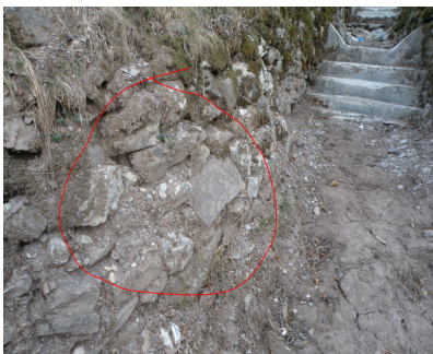
Segni di cedimento dei muri a secco del “sentiero canale” che convoglia l'acqua alla griglia (rif. su mappa: B)
