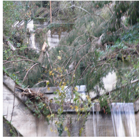
Briglie intasate da piante prima della pulizia del 1/11/18 (rif. su mappa: G)
