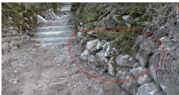
Segni di cedimento dei muri a secco del “sentiero canale” che convoglia l'acqua alla griglia (rif. su mappa: B)
