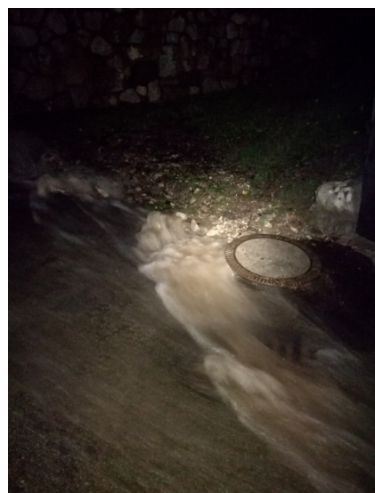
Tombini (il secondo, rotondo, è completamente aperto, il coperchio è appoggiato a valle) verso la fontana fronte latteria, all'altezza del retro del civico Toccol 79. (rif. su mappa: D)
